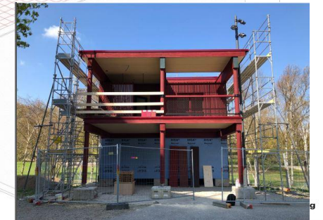
Mock Up als Pergola/ Treppenüberdachung
